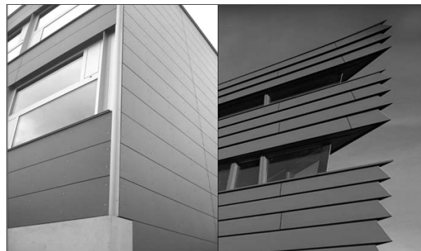
مزینات عایق‌کاری مرزانی پوسته خارجی ساختمان - بهروز کاری
