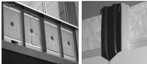
مزینات عایق‌کاری مرزانی پوسته خارجی ساختمان - بهروز کاری
