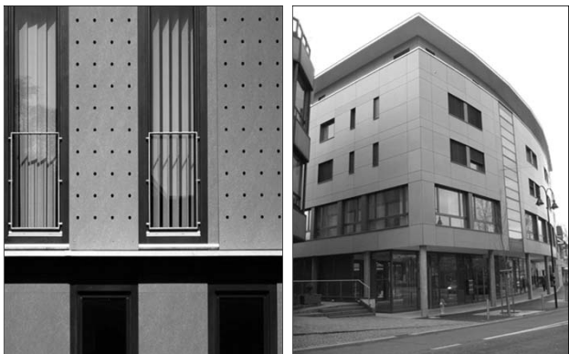
مزینات عایق‌کاری مرزانی پوسته خارجی ساختمان - بهروز کاری
