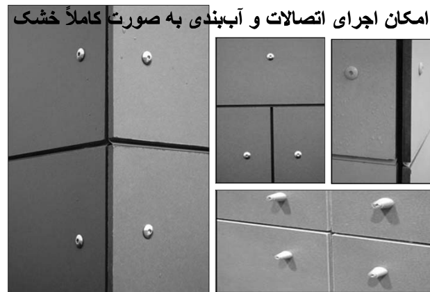
مزینات عایق‌کاری مرزانی پوسته خارجی ساختمان - بهروز کاری
