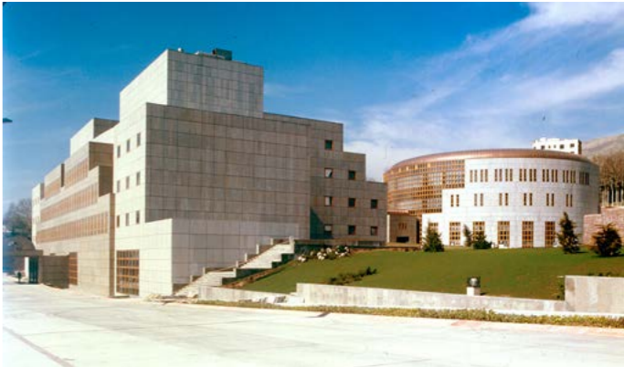
ساختمان حافظیه، مهمانسرای اجلاس سران
