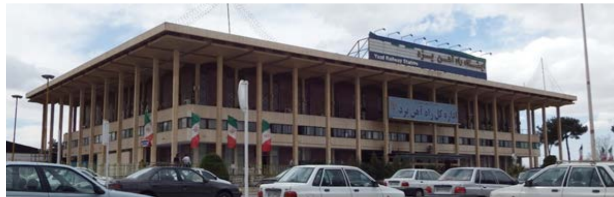
ایستگاه راه آهن
