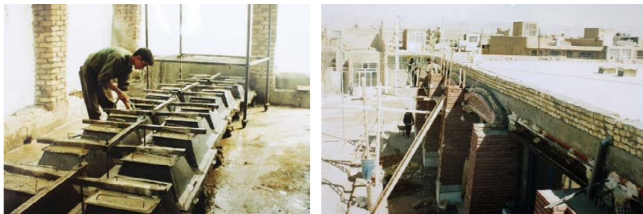
تصویر ۴: از بالا به پایین: یکی از مدول های کارگاهی، برج پله، فضای مابین کارگاهها، ورودی کلاس های نظری در طبقه اول، مراحل ساخت از آرشيو مدرسه
