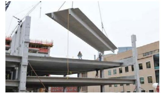
سقف دال‌های نیمه پیش ساخته بتن مسلح Double Tee با بتن روبه
