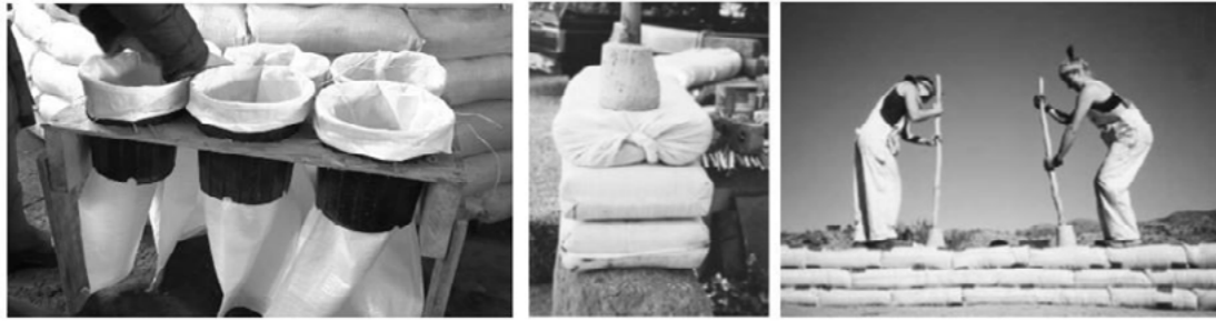
فرایند ساخت ابرخشت (منبع تصویر: Hunter and Kiffmeyer, 2004)
