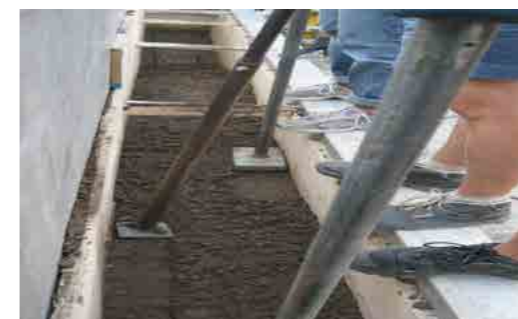
فرایند کوبش دیوار خاک کوبیده به دو شیوه دستی و مکانیکی (کوبنده پنوماتیک)
