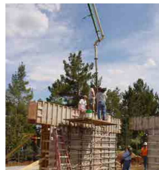
سیستم Poured Earth (منبع تصویر: greenhomebuilding.com)
