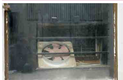
شکل ۴-۷۴ هواکش داخل دیوار ترومب
