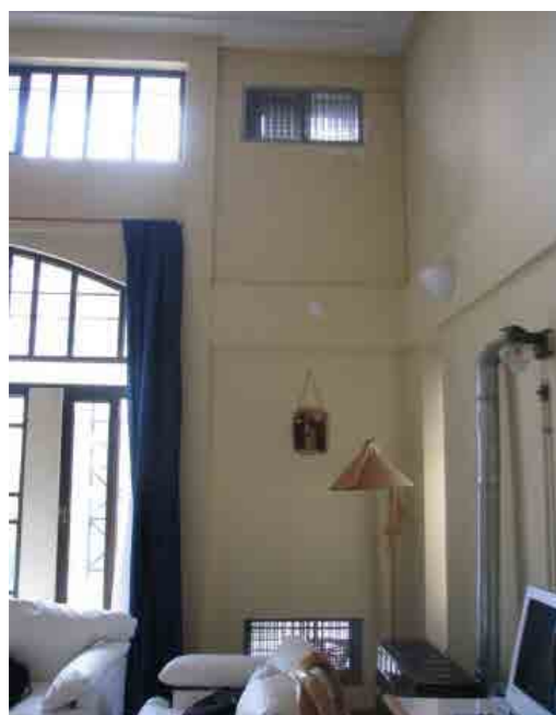
شکل ۴-۷۴ دیوار ترومب از داخل ساختمان
